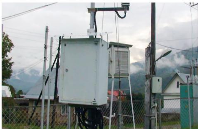
Рисунок 1. Датчики измерения мощности дозы в составе АМС
