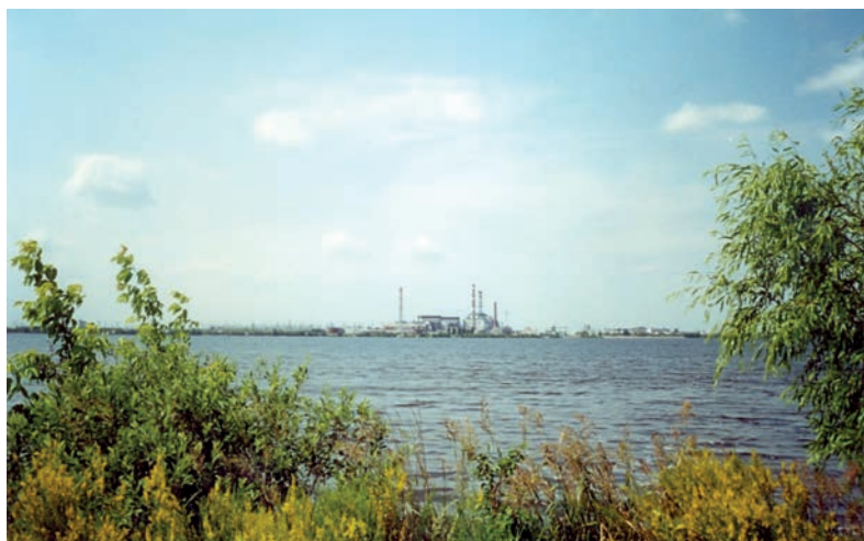
Рис. 6.1. Водоём-охладитель Чернобыльской АЭС
